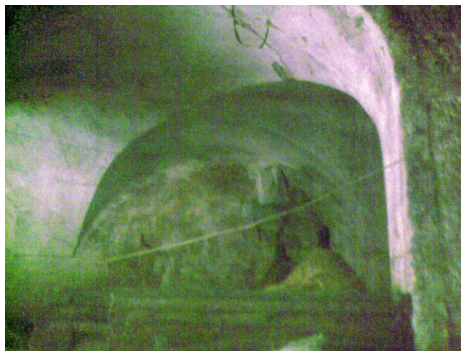
Fig. 1 - Resti delle arcate del chiostro, oggi completamente nascoste dalla sopraelevazione dell’edificio. La struttura si presenta ancora integra nel suo impianto originario.
